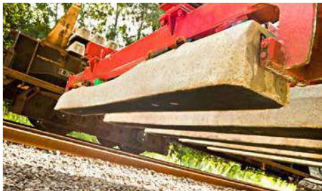
Besohlte Betonschwelle bei Einbau ins Streckengleis
