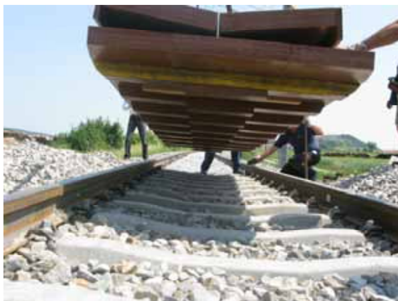
Vorgefertigte Eisenbahnkreuzung aus 3 Teilen
