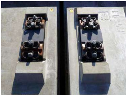
Einbausituation BSP FF-B-1, Beton
