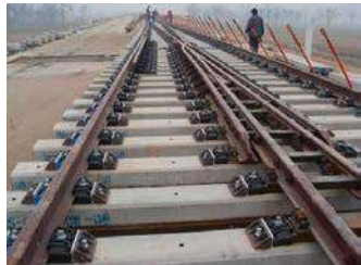
System 300 W, Einbausituation
